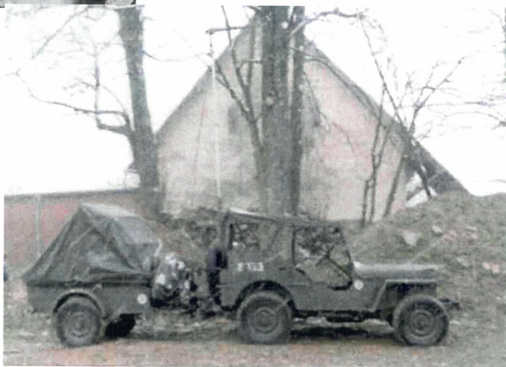
La jeep Ecureuil Elle comporte un QRTH en remorque 1/4 de ton- ne. On remarque l'antenne cigare
