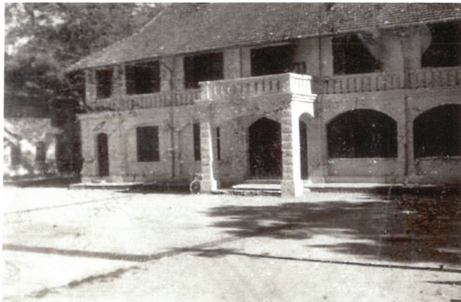
Hanoi, bâtiment de l'Etat-major des TAP Nord Centre de transmissions de la 342ème CT
